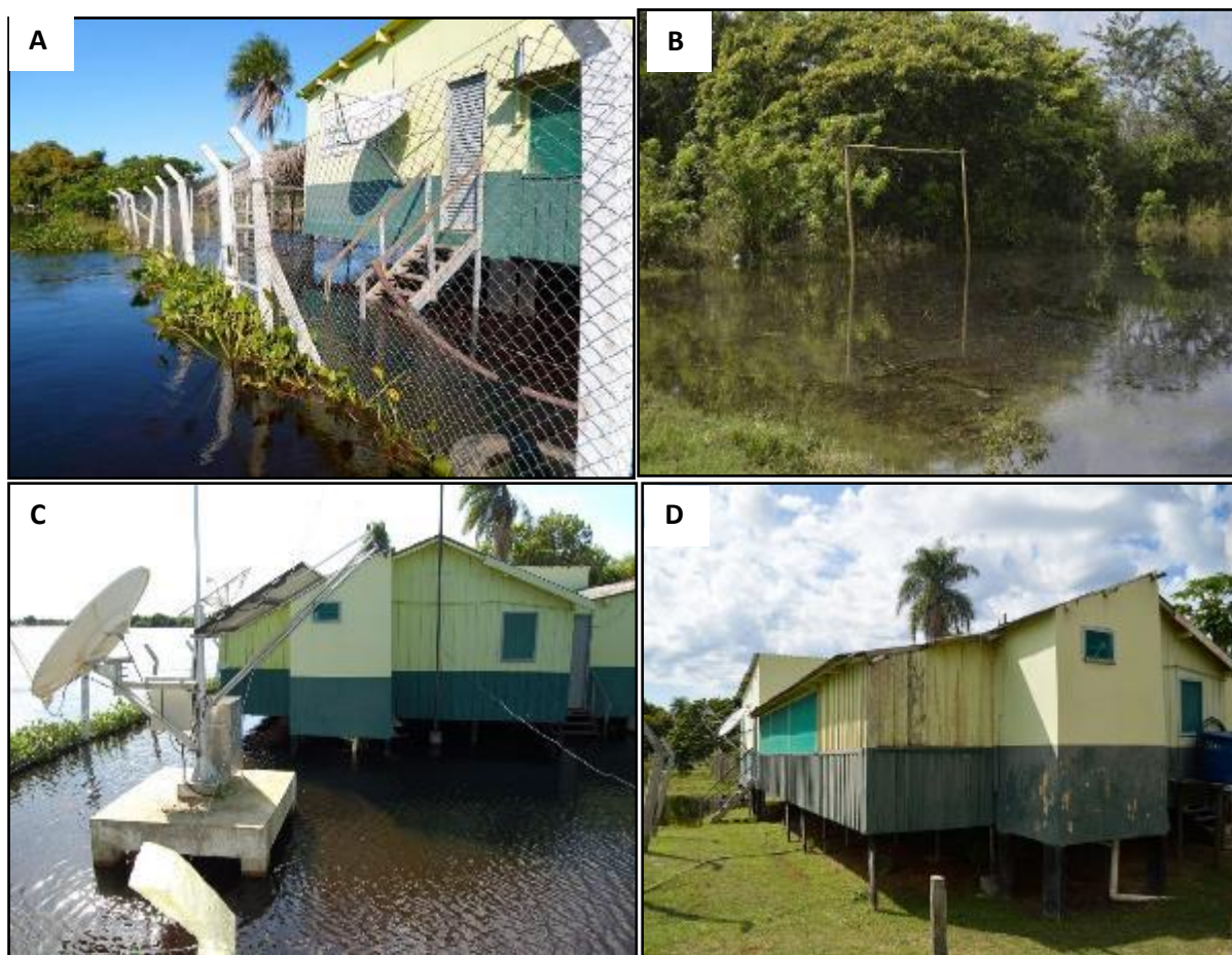
Figura 5 – Impacto da inundação na área da unidade escolar.
